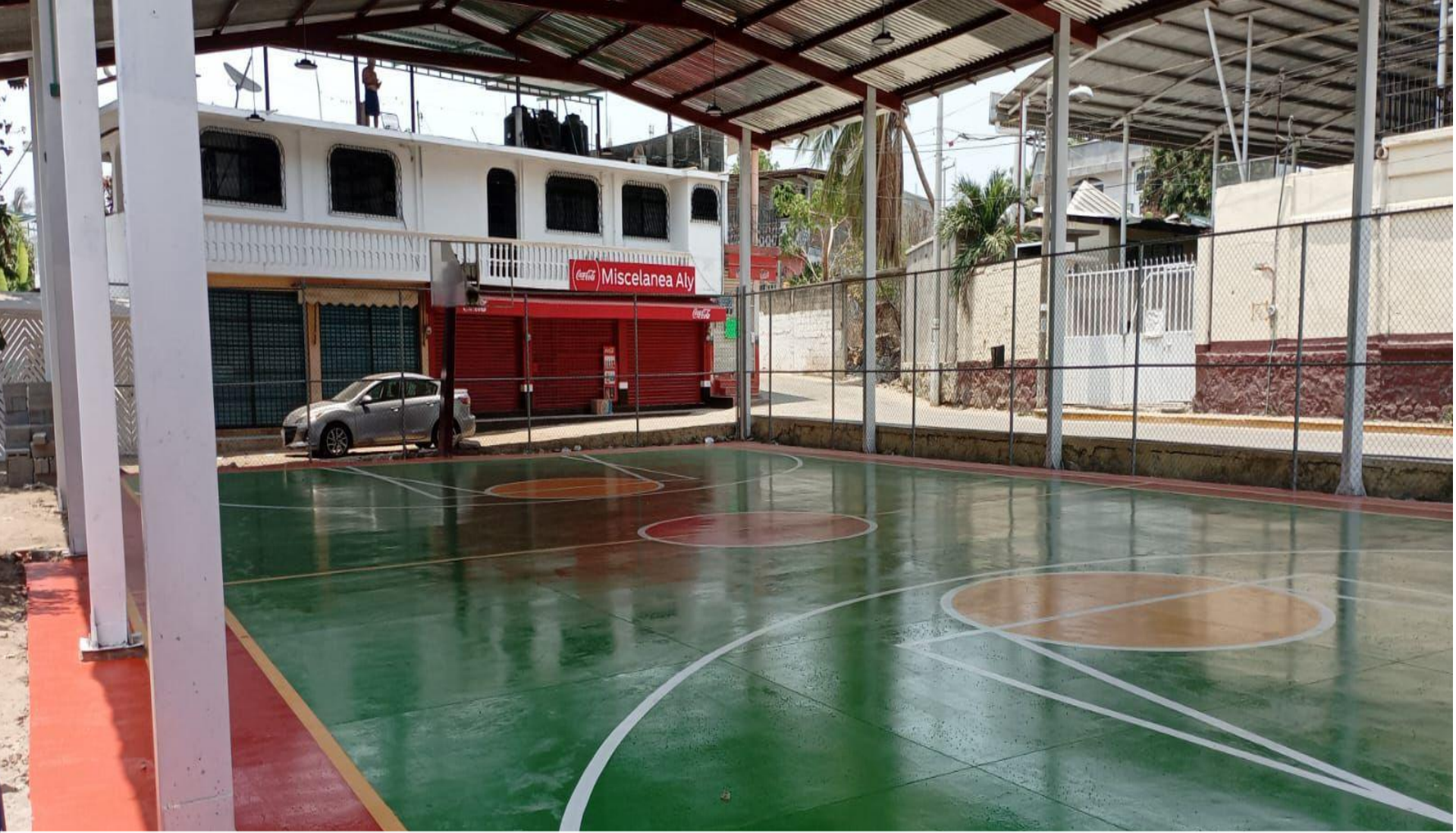
REMODELACIÓN DE CANCHA SAN ISIDRO, ACAPULCO; GUERRERO
